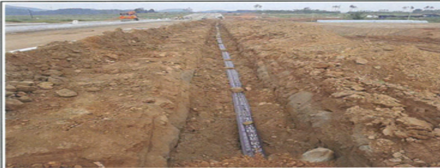
송수관로 되메우기 전경
