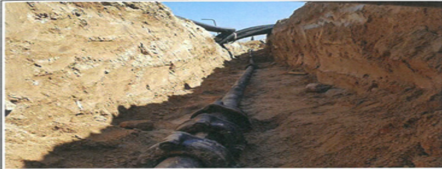
송수관로 부설 전경
